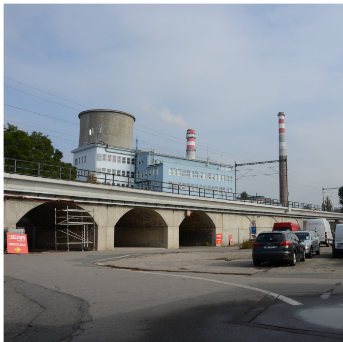
Pohled na viadukt a budovu EON
