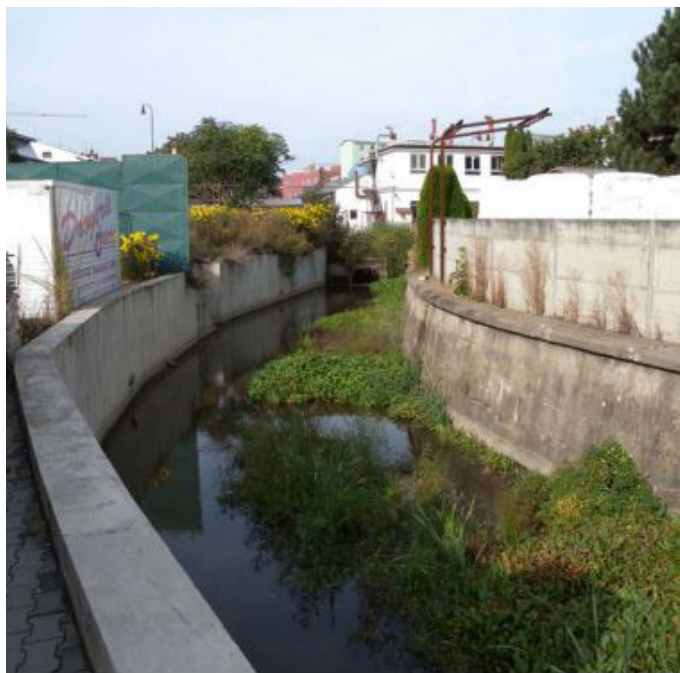
Opevněné koryto pod ulicí Tkalcovská
