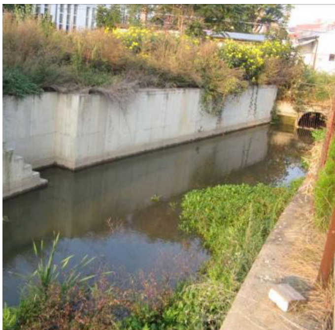
Vtok do dlouhého souvisle zatrubněného úseku mezi ul. Tkalcovská a Radlas
