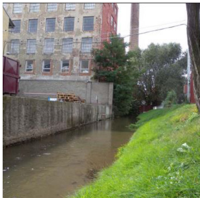
Areál Direct media, vyčištěná část toku. Tok Ponávky se plně zapojuje do zlepšení kvality prostředí.
