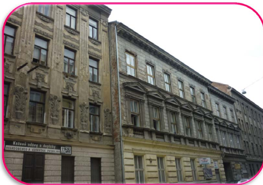
Obrázek č. 3 Typické původní historizující fasády se zvláštním charakteristickým „ošuntělým“ kouzlem, zdroj: foto Petra Sopoušková
